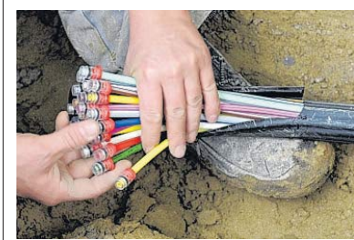
Der Glasfaserausbau startet 2023. FOTO: PETER KNEFFEL/DPA
